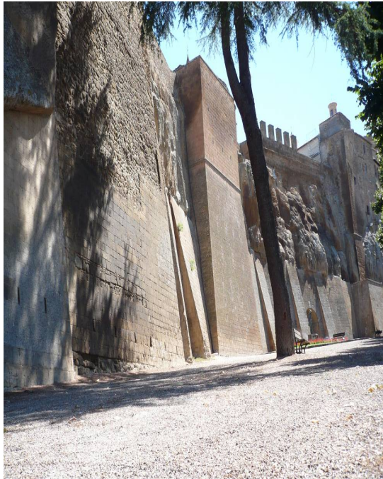
شكل (39:4) الصور أعلاه تظهر التجانس الكبير ما بين الصخرة وجدران التقوية أسفلها بعد تنفيذ أعمال التقوية والتثبيت.
