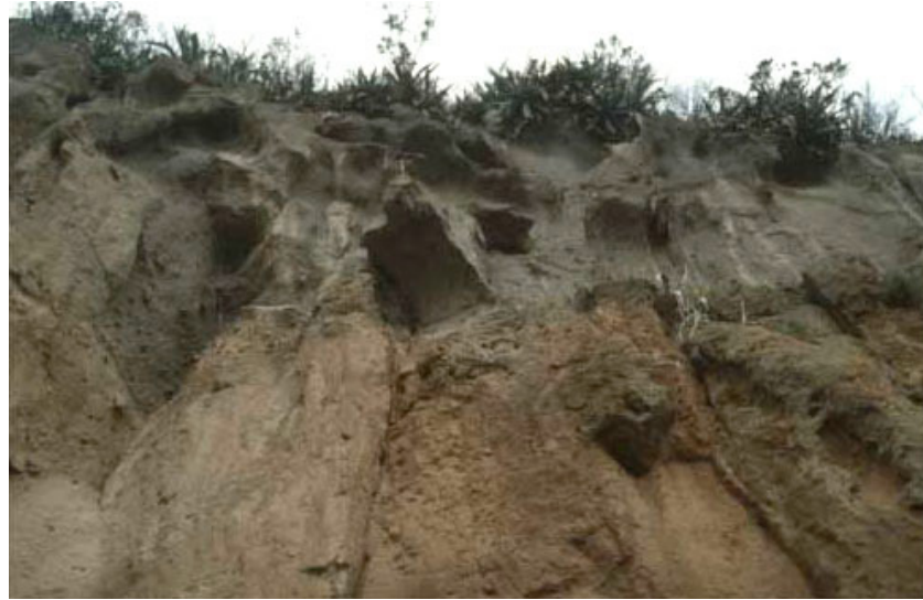
شكل (4:30): الصخرة ما قبل القيام بأعمال الترميم والتقوية، لاحظ وجود التشققات العمودية
