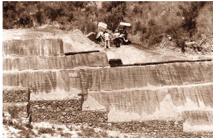
شكل (24:4): أعمال تثبيت جرت أسفل الجرف الصخري التقويم والتدعيم التربة.
