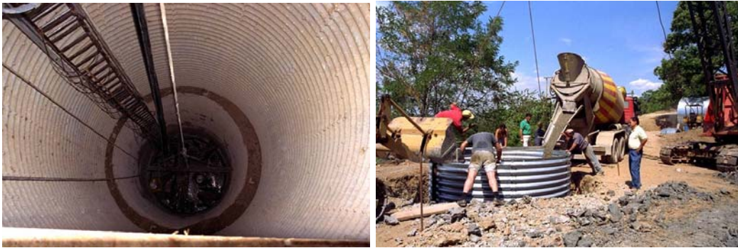
شكل (23:4): بئر تجفيف المياه في طبقات البورتوز.
