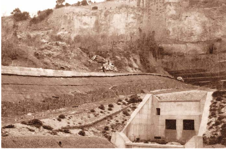
شكل (25:4): أعمال تسليح التربة وإنشاء عبارات كبيرة لتصريف المياه.
